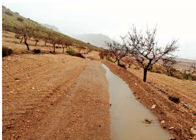
En la foto se muestra una zanja de infiltración “trabajando”.
